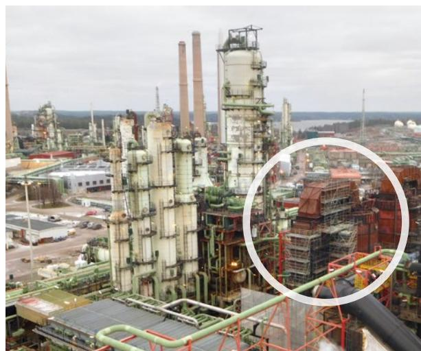
*Purettavat uunit viime vuoden lopulla, telineiden ympäröiminä paikoillaan. Uudet, keltaisilla huoltotasoilla ja kaiteilla varustetut uunit jäävät kuvassa savupiipun taakse oikealle.*
