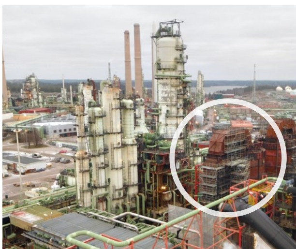
Purettavat uunit viime vuoden lopulla, telineiden ympäröimänä paikoillaan. Uudet, keltaisilla huoltotasoilla ja kaiteilla varustetut uunit jäivät kuvassa savupiipun taakse oikealle.
